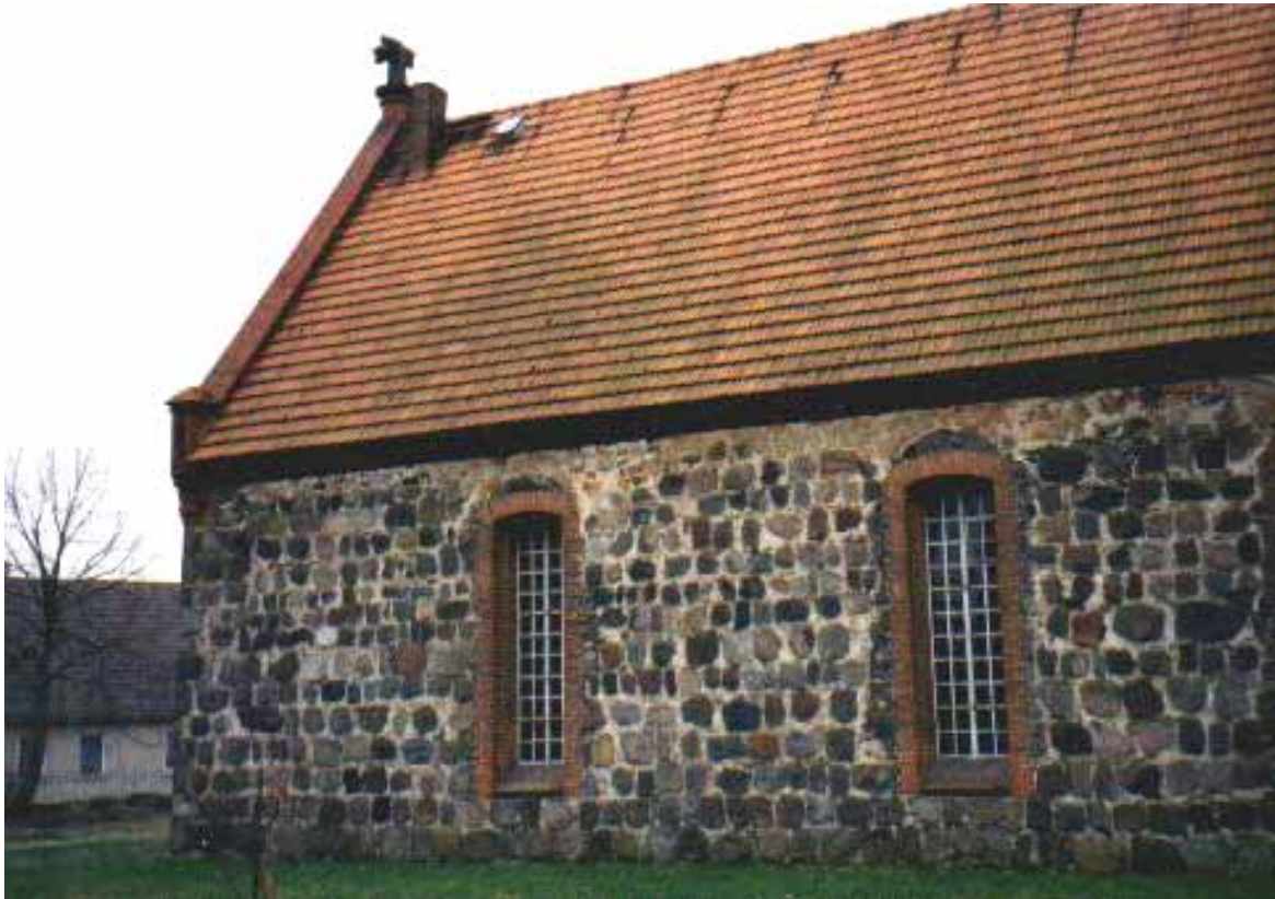
Die Bögen der barocken Fenster der Dorfkirche Ragow im Aufstockungsbereich sind über den neuen Fenstern noch zu erkennen.
