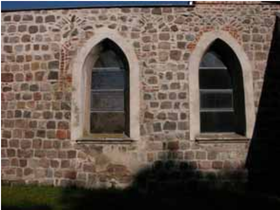
Dorfkirche Birkholz Südseite-Fensteröffnungen Fensteröffnungen
