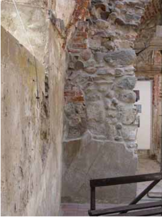
Dorfkirche Birkholz, ehem. Turmzugang von Osten
