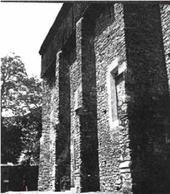
Kirchenburg Henndorf, Siebenbürgen, Strebepfeiler am Chor
