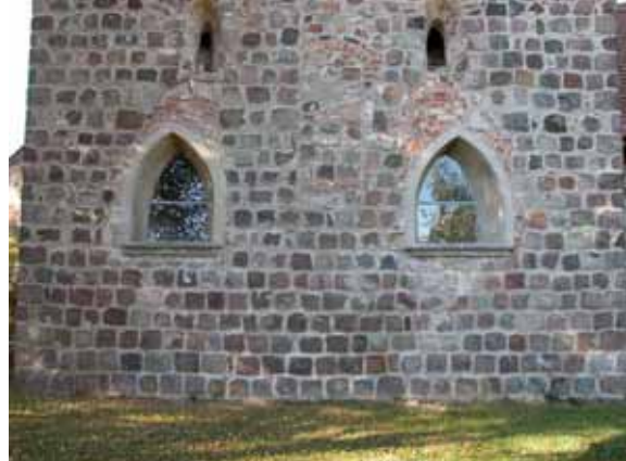
Dorfkirche Birkholz Ostseite- Fensteröffnungen
