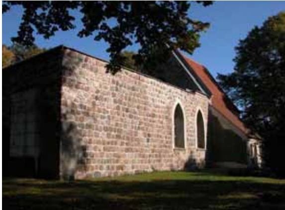
Dorfkirche Birkholz Südwestseite Leichenhalle
